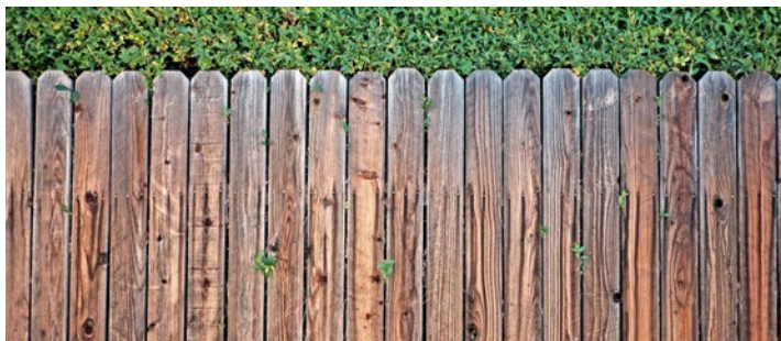
Bei toten Einfriedungen handelt es sich beispielsweise um Bretterwände oder Mauern. Bis zu einer Höhe von 1,80 Meter dürfen diese auf die Grenze gesetzt werden. Bild: z.vg.
